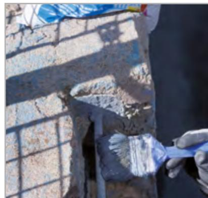
Рисунок 4.1 – Нанесение **Mapefer 1K** на арматурные стержни
