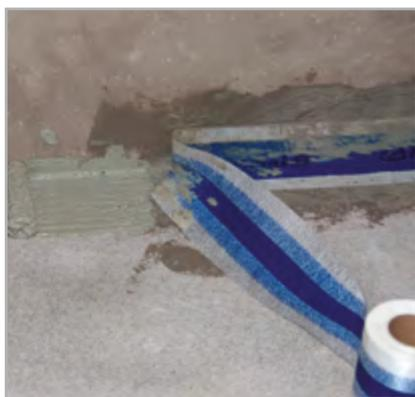
Рисунок 3.5 – Гидроизоляция и герметизация плинтусов между горизонтальной и вертикальной поверхностями с помощью ленты **Mapeband**
