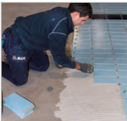
Рисунок 5.3 – Укладка облицовочного материала на дно бассейна
