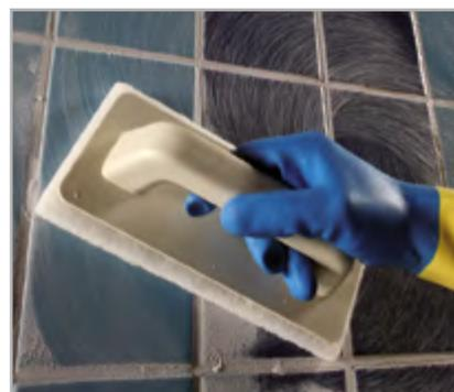
Рисунок 5.7 – Очистка поверхности плитки с помощью щетки **Scotch-Brite®**
