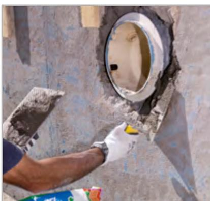
Рисунок 4.3 – Восстановление основания посредством **Maapegrout 430**
