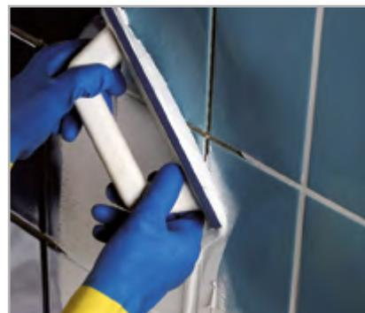
Рисунок 5.6 – Затирка облицовочного материала **Kerapoxy CQ**
