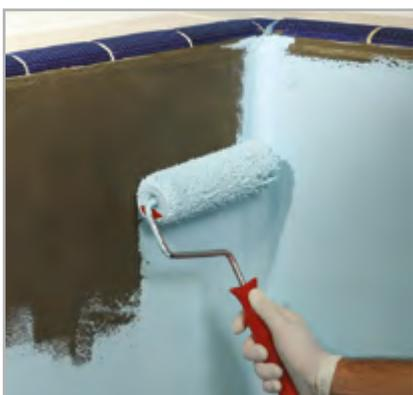
Рисунок 6.2 – Нанесение **Elastocolor Waterproof** с помощью валика
