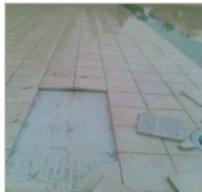
Рисунок 5.1 – Плитка, отделившаяся от основания из-за сдавливающих напряжений
