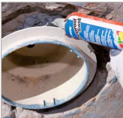
Рисунок 4.2 – Герметизация с помощью пасты **Maapeproof Swell**
