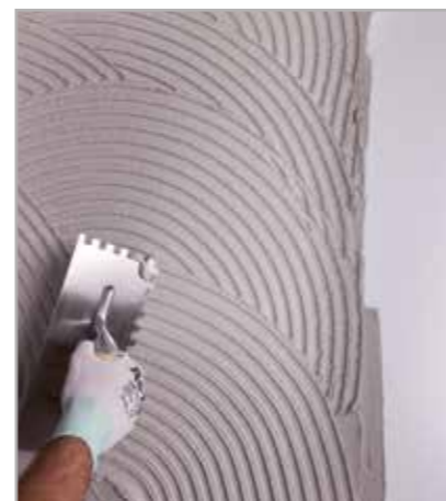
Рис. 6.11 - Нанесение первого слоя накрывочного состава
