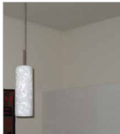
Комната в здании без наружной теплоизоляции
