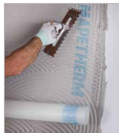
Рис. 6.12 - Укладка MAPETHERM NET
