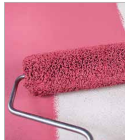
Рис. 6.14 - Нанесение цветной грунтовки
