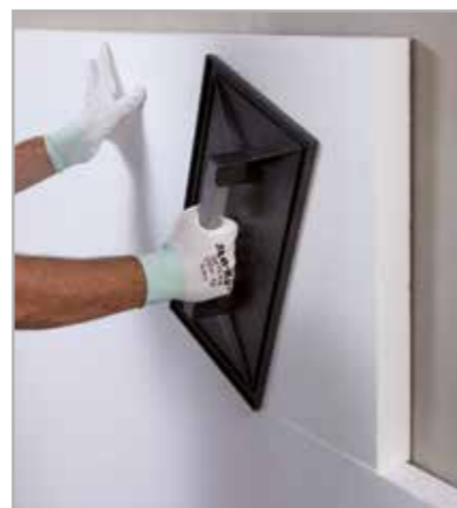
Рис. 6.8 – Придавливание панели гладилкой
