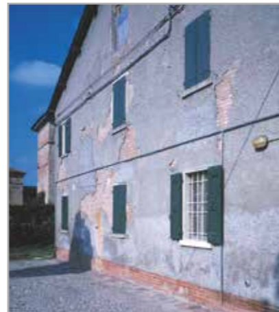
Fig. 6.2 - Отслаивающиеся куски штукатурки следует удалить, перед тем как приклеивать теплоизоляционную панель
