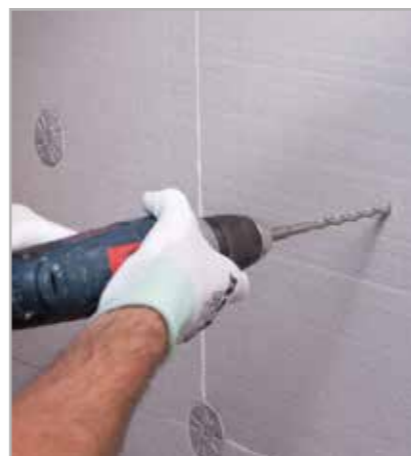
Рис. 6.9 - Сверление отверстия для вставки анкера
