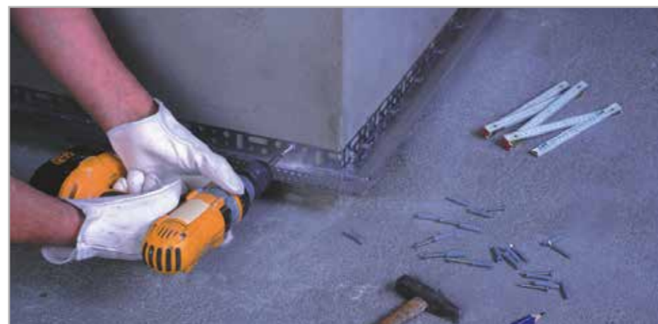
Рис. 6.4 – Закрепите поддерживающие профили с помощью дюбель-гвоздя
