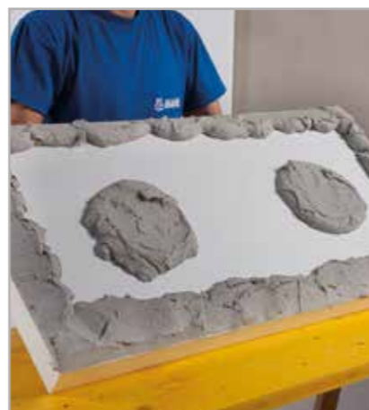
Рис. 6.6 – Обратная сторона панели с полосками клея по краям и локально нанесенным клеем в центре
