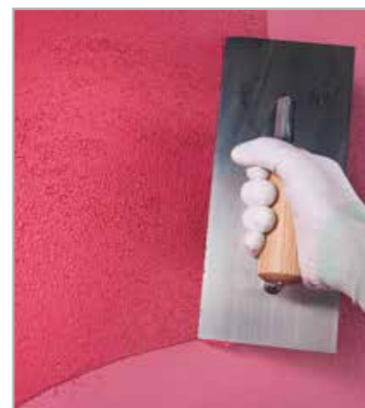
Рис. 6.15 - Нанесение декоративной штукатурки
